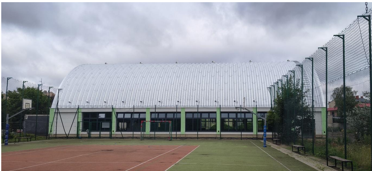
Zdjęcie Nr 11. Widok na elewację wschodnią
