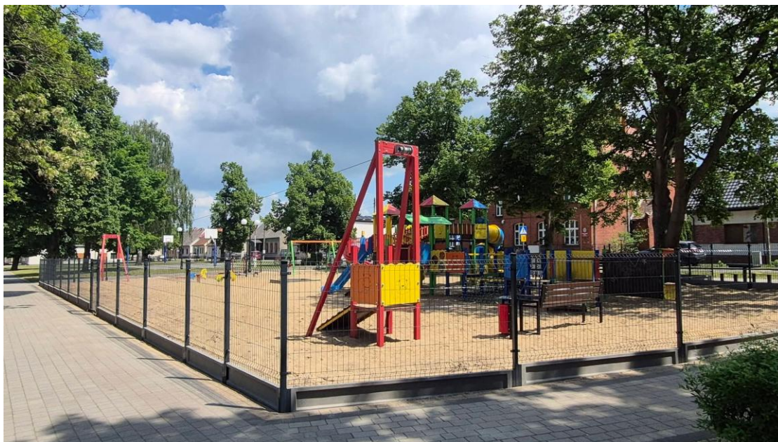
Zdjęcie Nr 10. Ogrodzenie placu zabaw Źródło: Opracowanie własne
