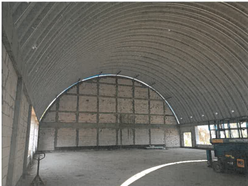
Zdjęcie Nr 3. Widok wnętrza, ściana północna
