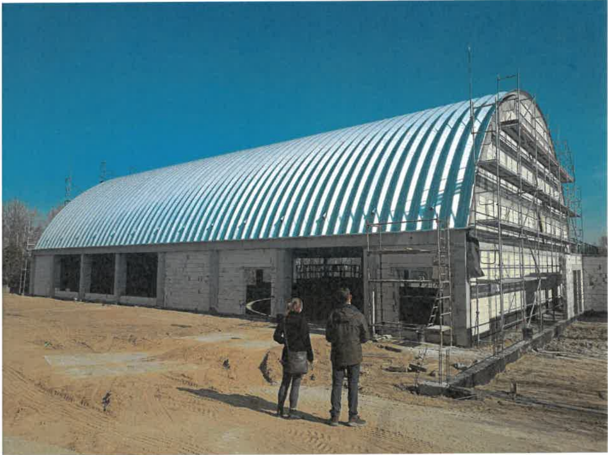
Zdjęcie Nr 1. Widok na elewację zachodnią
