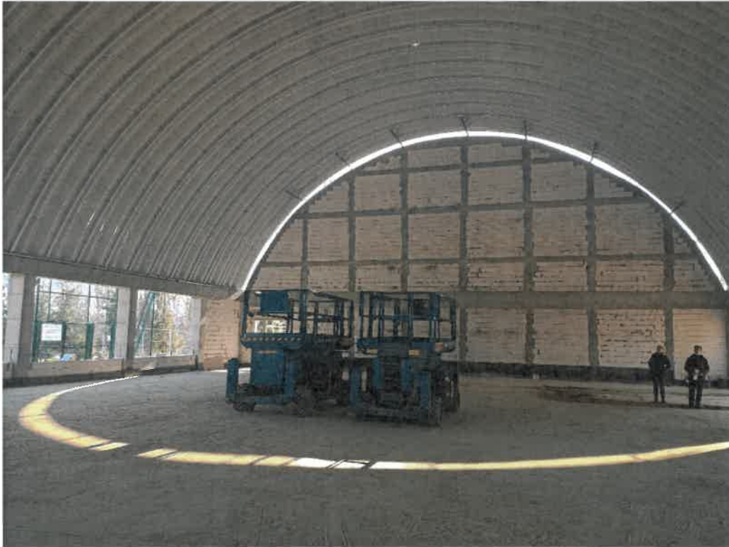
Zdjęcie Nr 2. Widok wnętrza, ściana południowa
