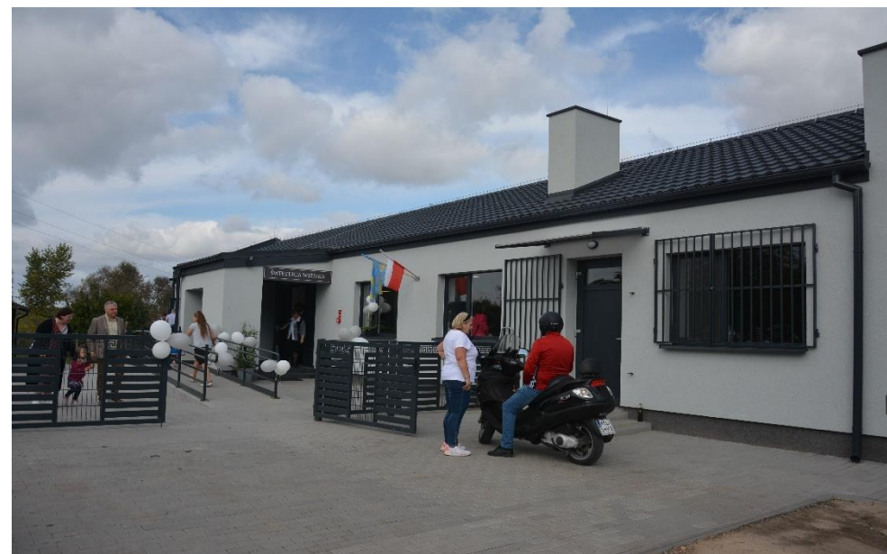
Fotografia: świetlica wiejska w Pałdziu Dolnym
