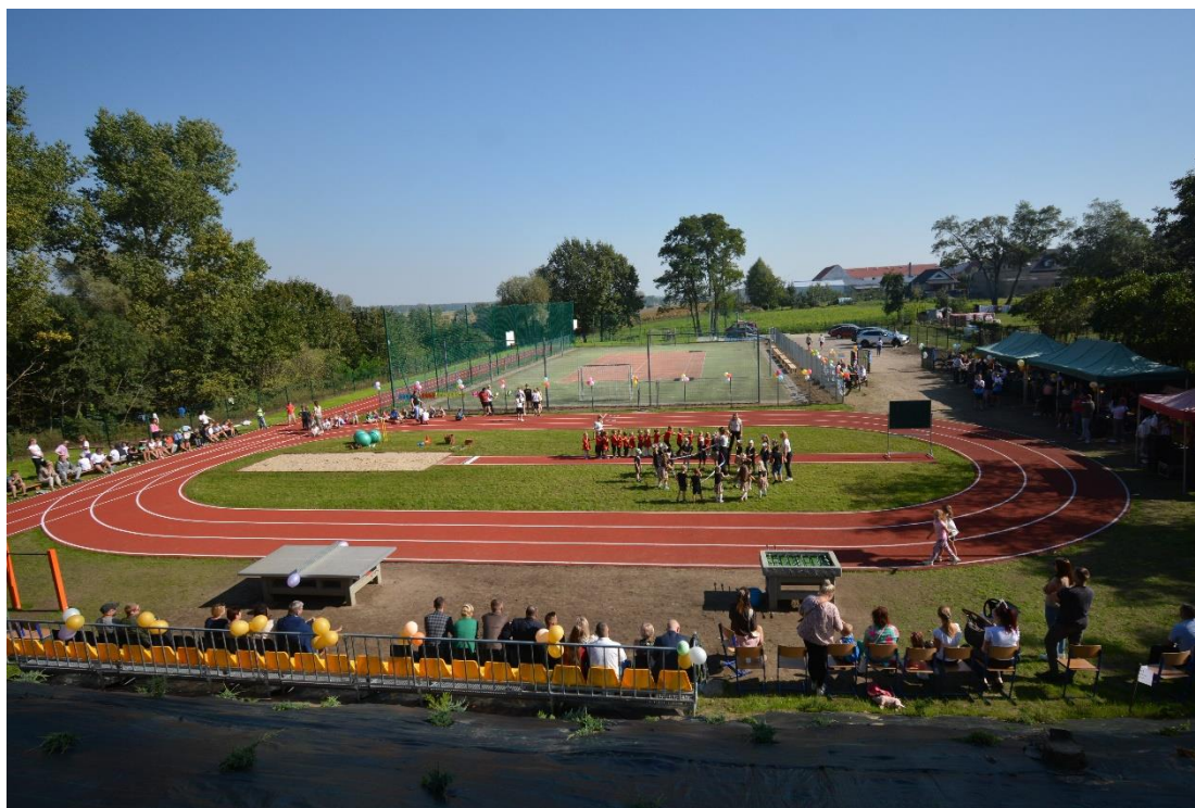
Budowa i przebudowa ogólnodostępnych obiektów infrastruktury rekreacyjnej w m. Padniewo
